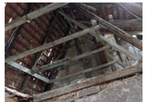
Hohe Straße 19 vor der Sanierung
