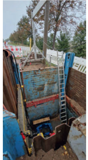
Startgrube für den Rohrvortrieb in der Bundesstraße B 180
