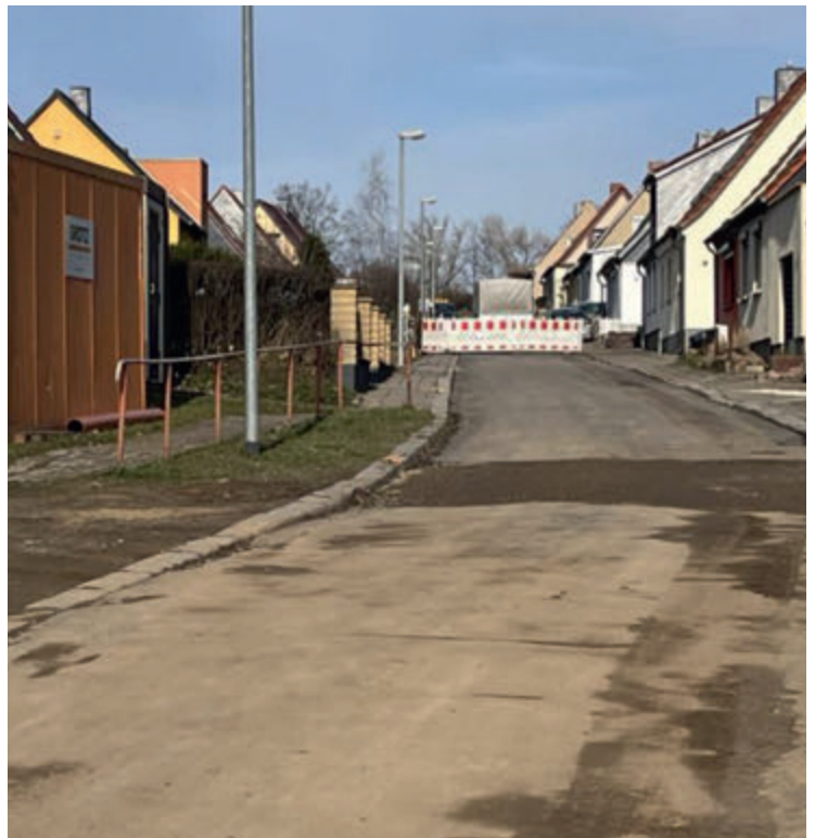
Kanalbauarbeiten in der Maxim-Gorki-Straße
