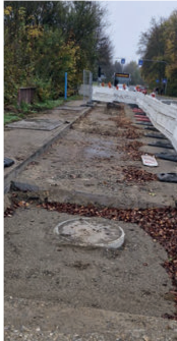
Verbindungskanal entlang der Bundesstraße B 180
